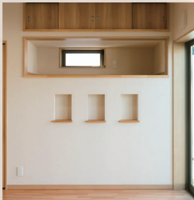
外断熱工法により壁厚収納。そして外部収納との取り合いで隙間空間を利用しています。
